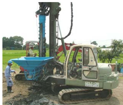
エコジオ工法による地盤改良の様子
