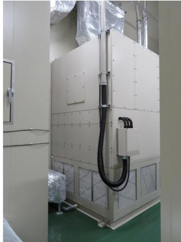
試験室AHU(室内機)
