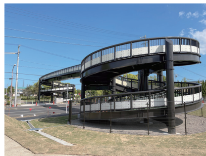
▶ 笹川パークブリッジ（三重県四日市市） 50年使用した歩道橋を補修・移設しました。 この先50年の利用を目指します。
